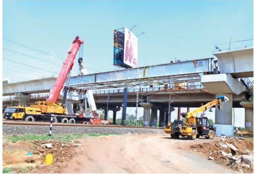
एमआर-10 स्थित रेलवे लाइन पर स्टील गर्डर को चढ़ाती क्रेन। ● नईदुनिया
