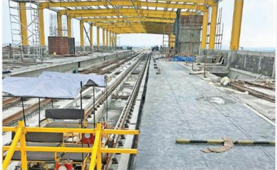
स्ट्रक्चर गेज के माध्यम से निर्धारित मापदंड से बाहर निकले प्लेटफार्म के सीमेंट कांक्रिट के हिस्सों को कटर से काटा जा रहा है। ● नई दुनिया
