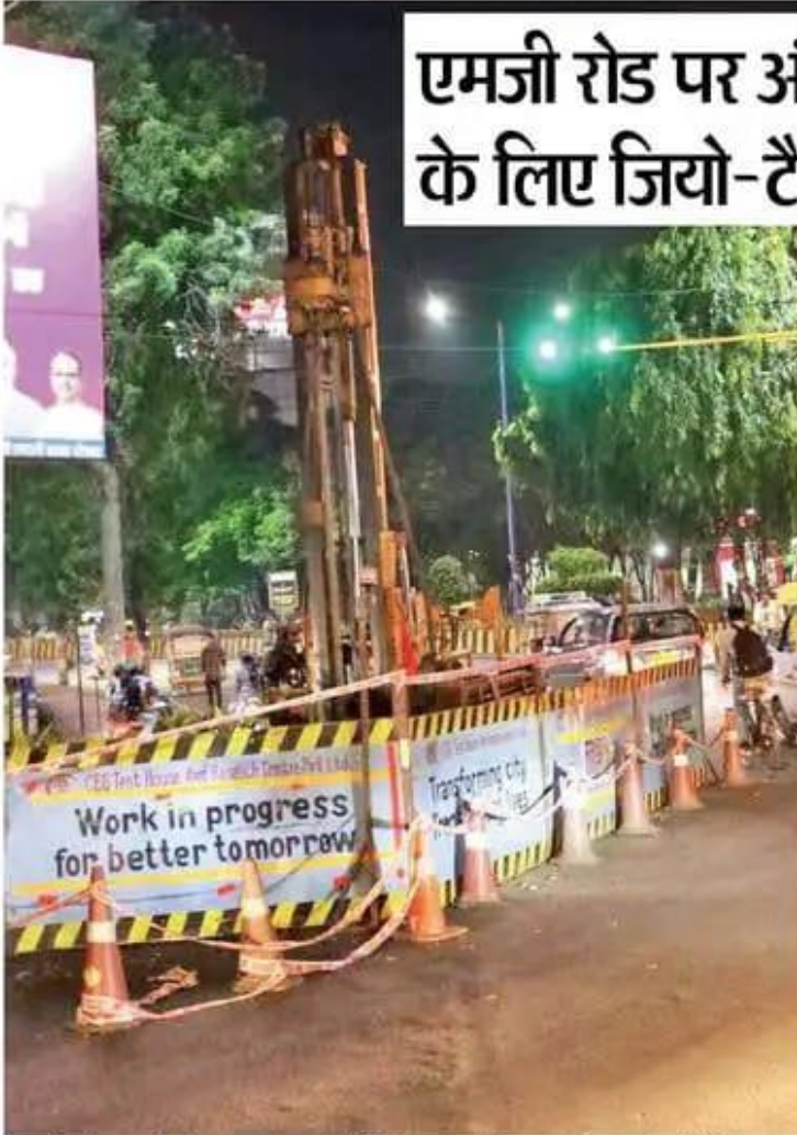
मिट्टी परीक्षण के लिए आसपास बैरिकेडिंग कर बोरिंग मशीन लगाई गई है।
