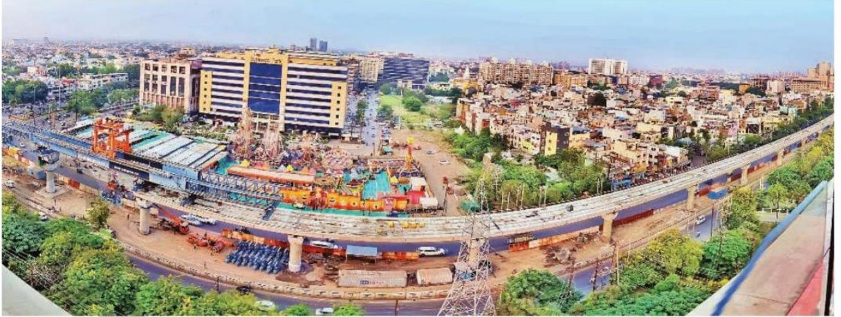
आकार लेती इंदौर मेट्रो... शहर में मेट्रो का काम काफी तेज गति से चल रहा है। पहले चरण के तहत 17.5 किमी के मेट्रो ट्रेक को बनाने के लिए खंड लांचमेंटी की मदद ली जा रही है। रैडिअस चौगहे से लेकर विजय नगर के बीच बिन्दुओं को जोड़ने के लिए लांचमेंटी की सहायता ली जा रही है। एक लांचमेंटी को पांच दिन में संगमेट की सहायता से जीव देता है, अब इस इलाके में मेट्रो ट्रेक नज़र आने लगा है। कोलकाता की एक कंपनी को इन ट्रेक पर बट्टरी विद्युत का ठेका दिया जा चुका है, वहीं अगले साल सितंबर में सुपर कार्किबर के 5.5 किमी के हिस्से में मेट्रो का ट्रायल रन किया जाएगा। ● प्रमुख खबरें 'आज'
