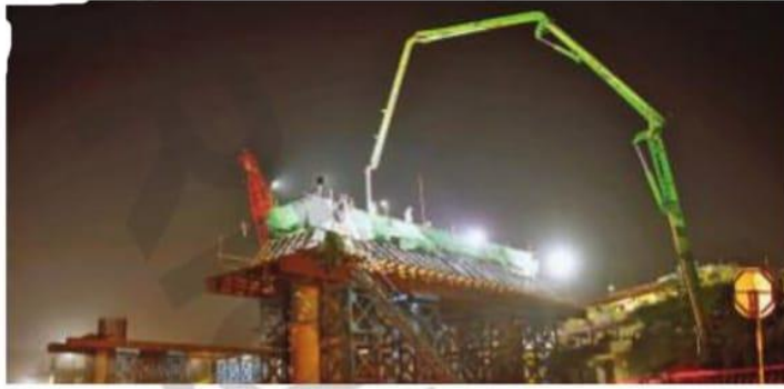
एमआर-10 ब्रिज के पास मेट्रो स्टेशन का निर्माण दिनों और रात दोनों पालियों में चल रहा है। ● नईदुनिया
