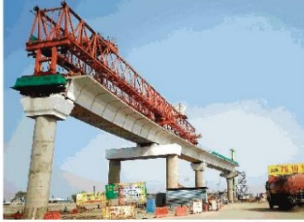
एमआर-10 के पास लाचर से पिलर पर सेगमेंट लगाए जा रहे हैं। ● नईदुनिया
