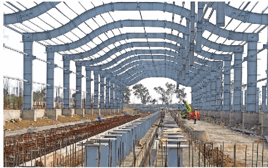
मेट्रो के निरीक्षण यार्ड में पिछला एक लेन के ट्रैक पर 126 स्टील के पिलर लगा दिए गए हैं। यहां भी काम तेजी से चल रहा है। नईदुनिया
