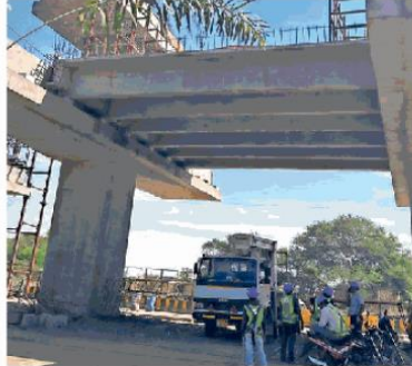
प्रायोरिटी कारिडोर पर पाई गार्डर लांच करने का काम जारी है। हर स्टेशन पर करीब 400 पाई गार्डर लगाई जाएगी। ● नईदुनिया
