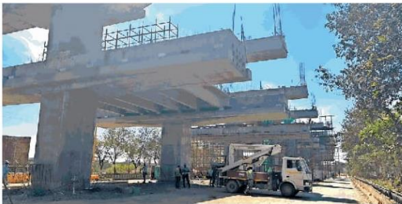
शहर में मेट्रो का काम तेजी से चल रहा है। प्रायोस्टी कारिडोर पर पांच पाई गर्डर लांच की गईं। • नईदुनिया
