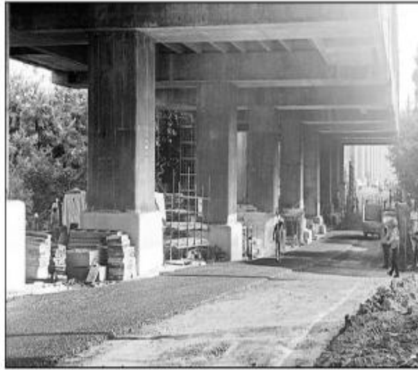
केंद्रिय विद्यालय मेट्रो स्टेशन के नीचे के हिस्से में सड़क निर्माण का काम चल रहा है।
