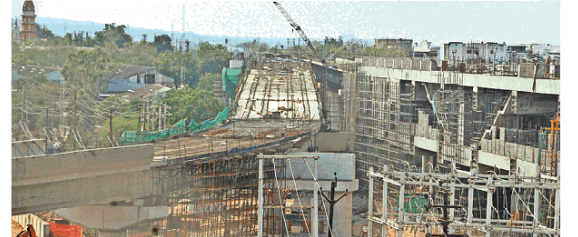
सुभाष नगर फाटक के पास निर्माणधीन मेट्रो स्टेशन का निर्माण कार्य किया जा रहा है। ● नवदुनिया
