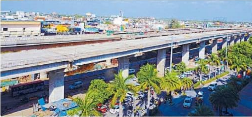
भोपाल, राजधानी में विकास कार्य तेजी से चल रहा है। शहर में एक और मेट्रो ट्रेन चलाने के लिए टैंक बनवा जा रहा है तो बुलंदी और सड़क और जोवर ब्रिज का निर्माण जारी है।
