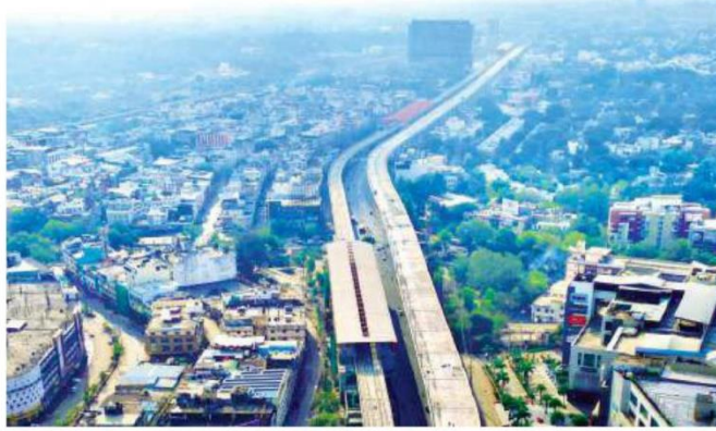
भोपाल मेट्रो टेंडर की अरिज लाइन का टैक सुभ्र नगर से गंगी कामगुड़ी स्टेशन और गोशा मंदिर से गणेश मंदिर का फ्लॉइओवर दोनों प्रोजेक्ट का काम अब अग्रिम चरण में है। इन दोनों प्रोजेक्ट के तैली से डुर निर्माण कार्य को ड्रूम से ली गई तस्वीर के जरिए दिखाया गया है। फोटो: सौजन्य - मंदिर सिंह
