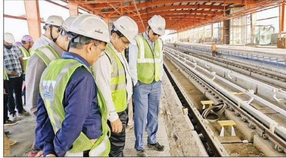
मेट्रो कंपनी के एमडी एस कृष्ण चैतन्य बुधवार को मेट्रो स्टेशन का निरीक्षण करते हुए।
