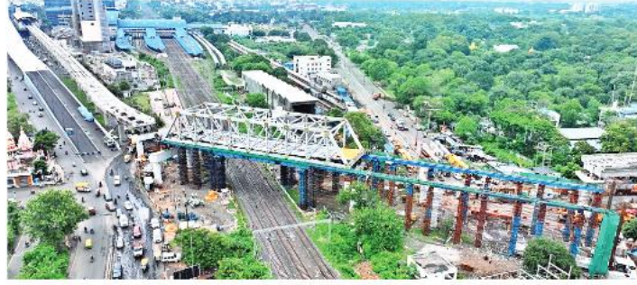
डीआरएम आफिस के बीच रेलवे लाइन के ऊपर 65 मीटर लंबा स्टील ब्रिज रखा गया। • नवदुनिया
