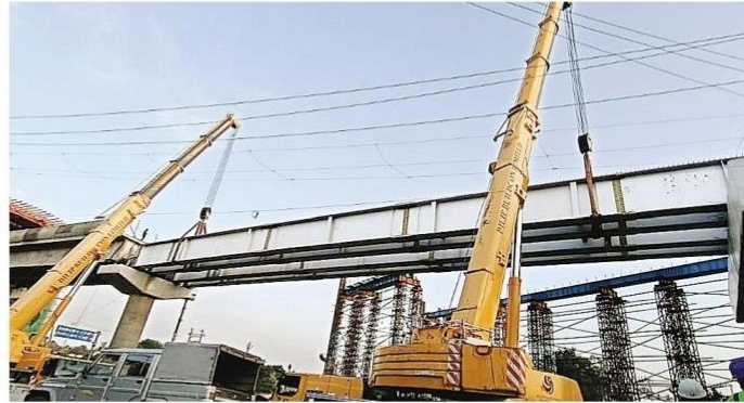
डीआरएम तिराहे पर सोमवार को क्रेन की मदद से स्टील ब्रिज के लिए गर्डर लॉन्च किए।
