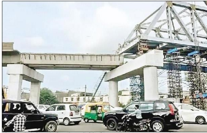
भोपाल। मेट्रो ट्रैक पर ब्रिज के सपोर्ट के लिए रखा गया स्ट्रक्चर हटा लिया गया।
