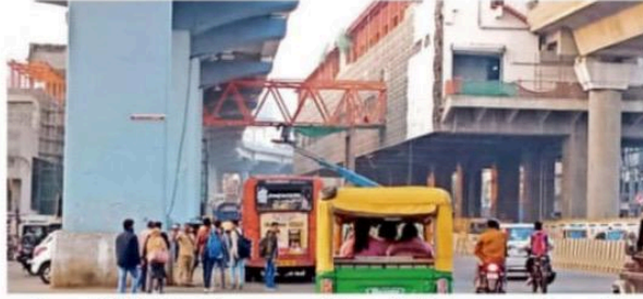
एमपी नगर डीबी सिटी मेट्रो स्टेशन पर एफओबी का स्टील ब्रिज रखा गया। ● नवदुनिया
